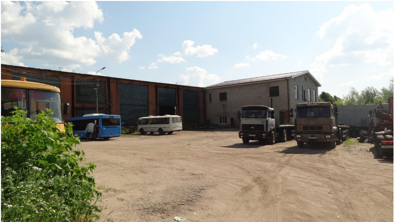
Фото 9. Вид с севера на помещение 1 в стр. 7 по адресу: Калужская область, г. Боровск, ул. Коммунистическая, д. 63. Данное помещение имеет Г-образный вид на плане и состоит из двухэтажного здания из силикатного кирпича (справа) и стоянки-модуля из красного кирпича.
