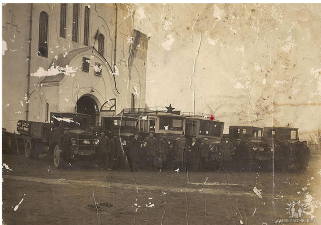
1930-е годы. Боровск. Автоколонна. (Размещалась в Покровском соборе)
