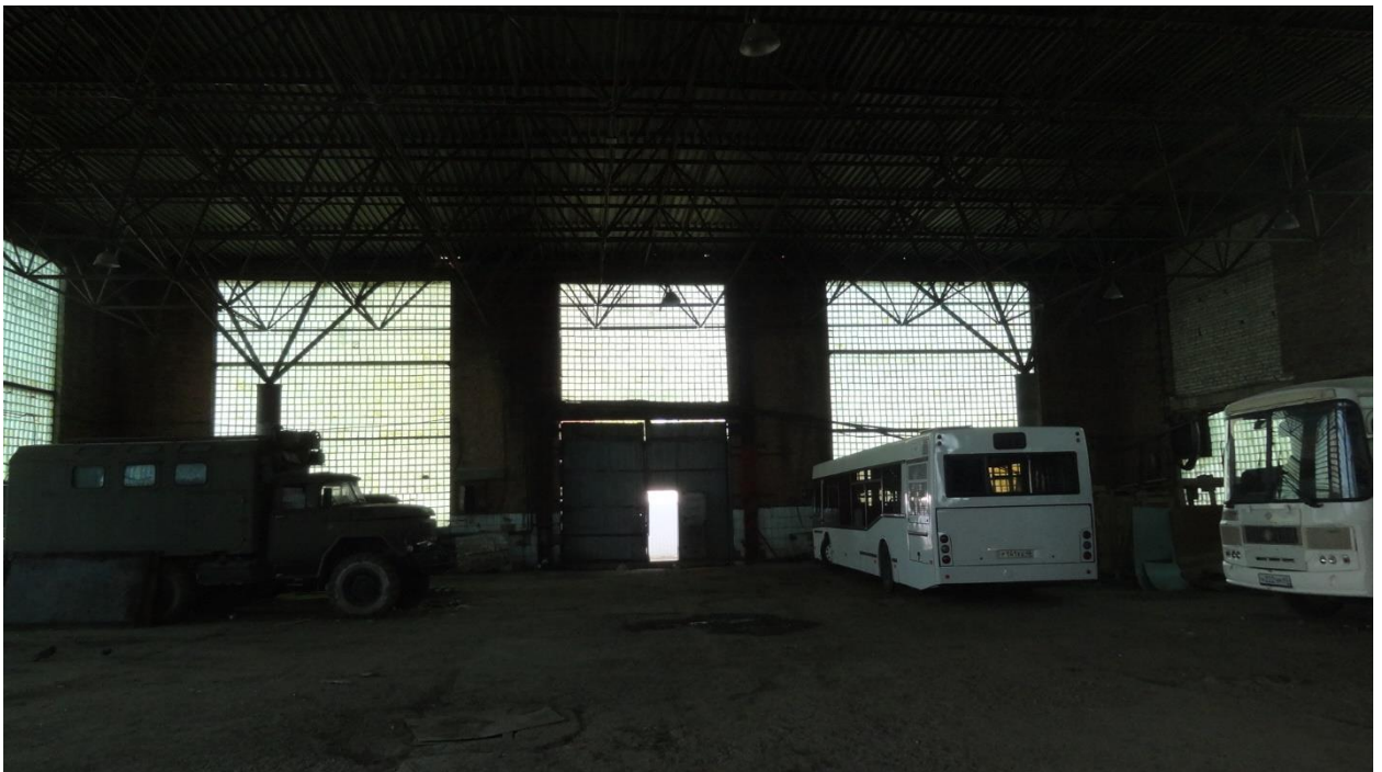
Фото 14. Вид изнутри на восточную часть стоянки-модуля.
