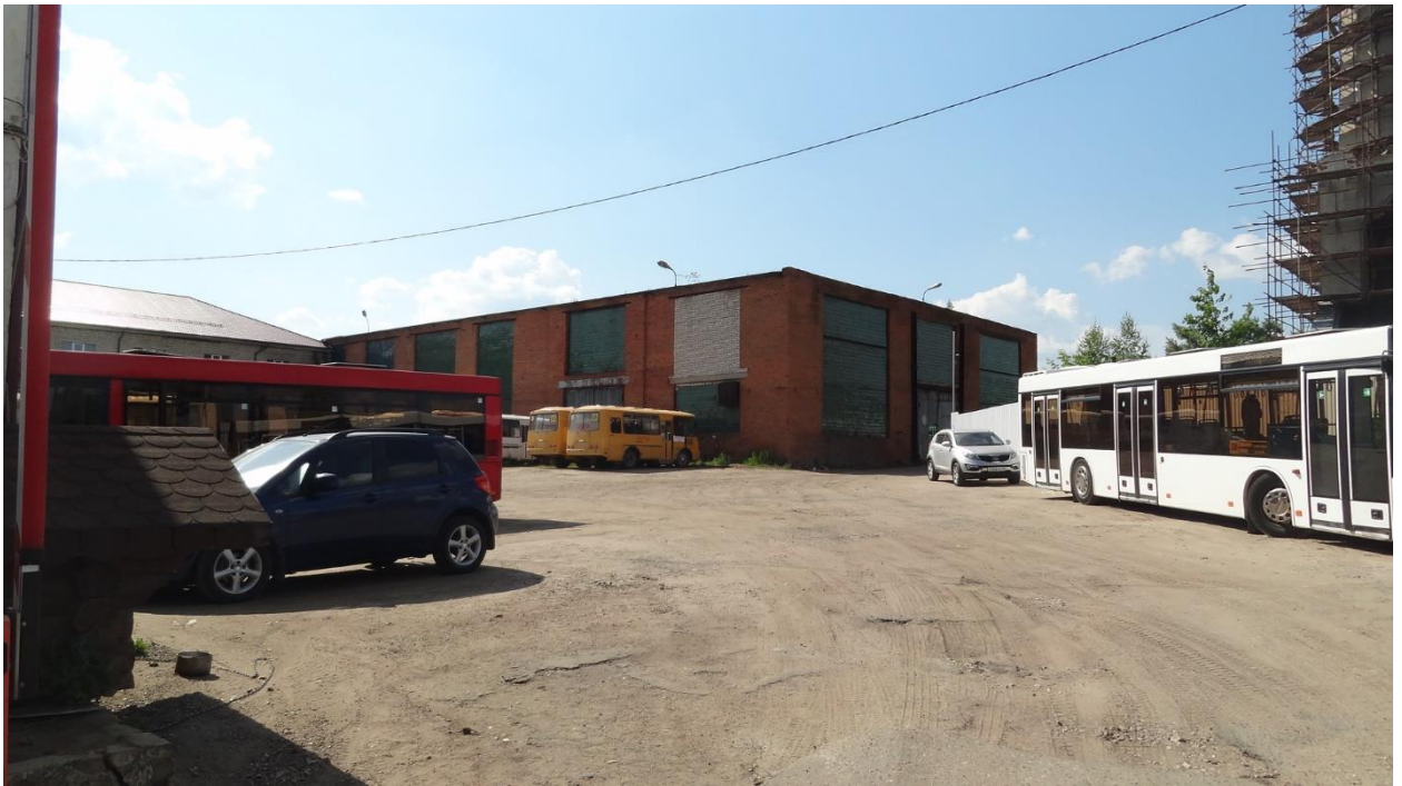
Фото 3. Вид на сносимый строительный объем кирпичного здания стоянки-модуля. Здание является явно диссонирующим относительно реставрируемого Покровского собора.
